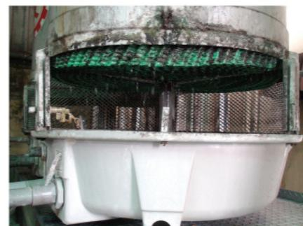
水垢造成散熱填充材塌陷
